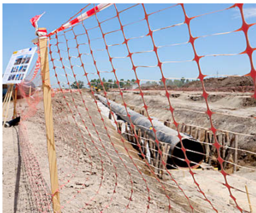
Las obras principales ya alcanzan un 35% de ejecución. Ministerio de Agricultura
