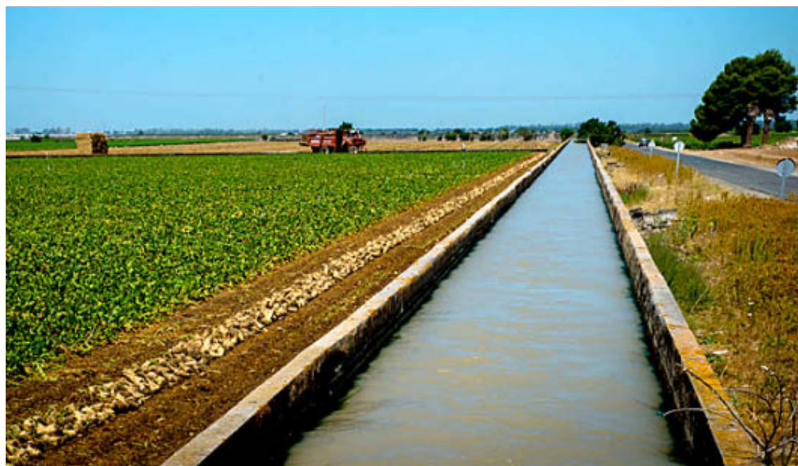
Se sustituirán todos los canales y acequias. CR Marismas del Guadalquivir
